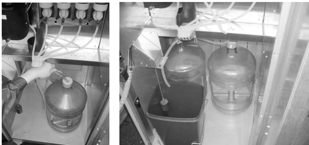
Рисунок 22 — установка автономного комплекта водоснабжения.
